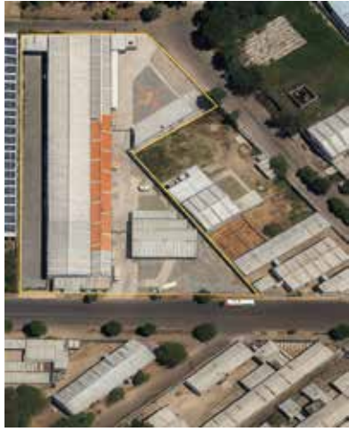
FERRETERIA ACEROS 2000 LA CRUZ 11,900 mts 2
