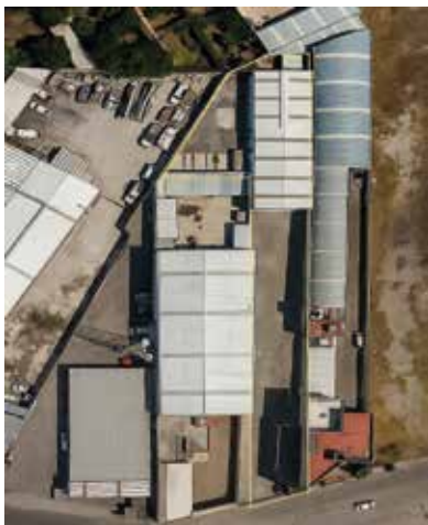
FERRETERIA ACEROS 2000 SAN PABLO, MEZQUITAL 4 1,700 mts 2
